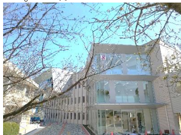
4/1竣工の8号館！新しい建物で学べる嬉しさ！
